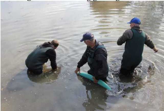
Der Saugkorb muss ständig gereinigt werden
